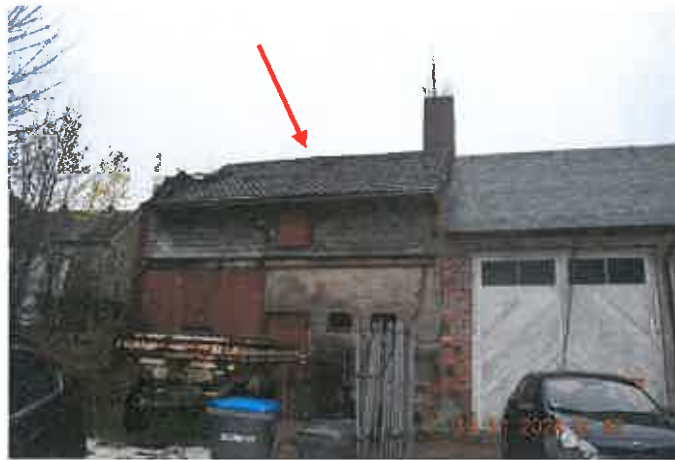
Außenansicht von der Schmalkalder Straße aus
