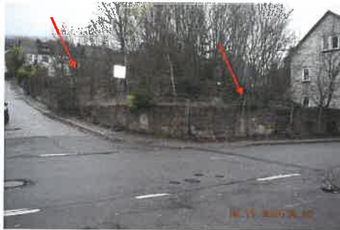
Ansicht Eckbereich Bachstraße/Schmalkalder Straße
