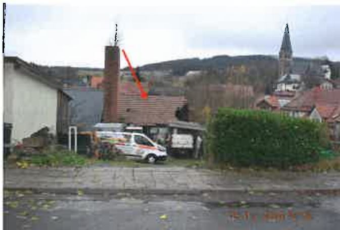
Außenansicht von der Seimbergstraße aus
