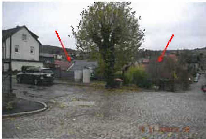
Außenansicht Eckbereich Seimbergstraße/Bachstraße
