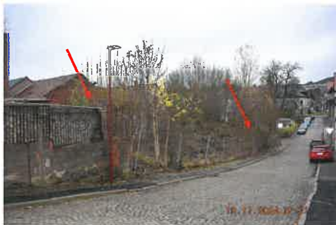
seitliche Ansicht Bachstraße
