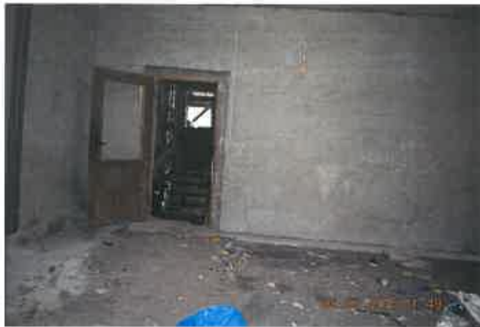
Zugang von Garage zum Scheunenanbau
