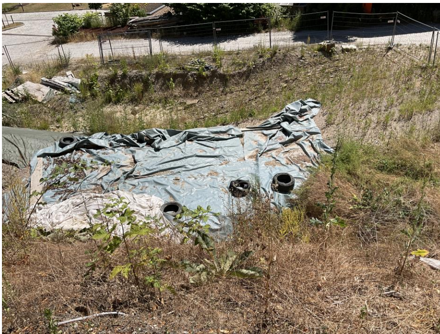
Begonnener Aushub Baugrube auf Flurstück 82/6
