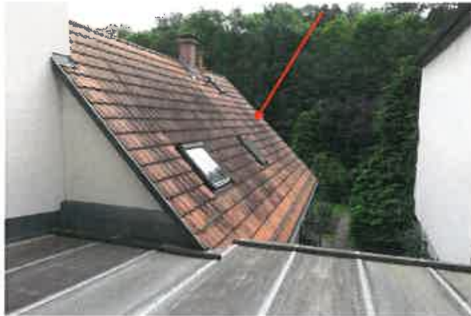
Dachansicht Hinterhaus Eigentumswohnung Nr. 1
