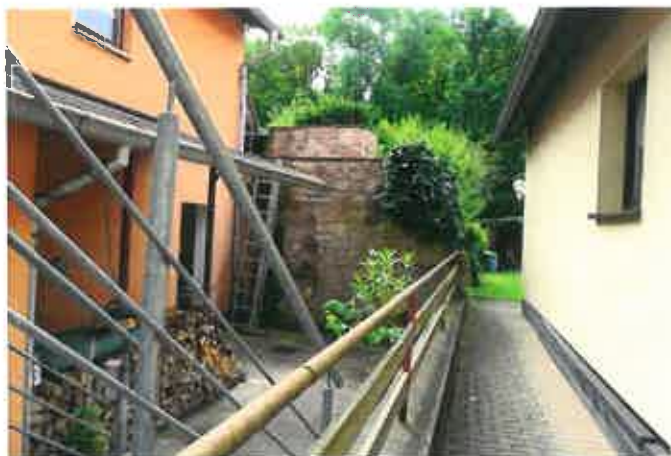
seitlich Ansicht und Zuwegung zum Gartenbereich
