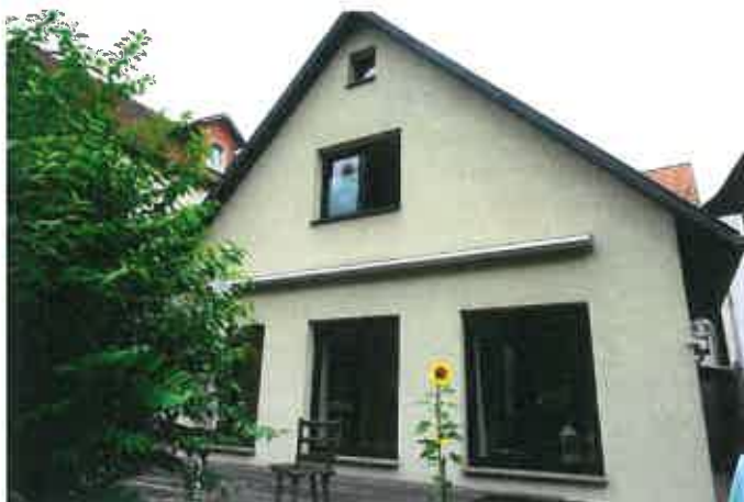
rückwärtige Gebäudeansicht Eigentumswohnung Nr. 1
