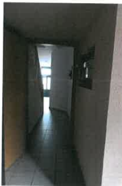
Treppenhaus Erdgeschoss, Gemeinschaftseigentum Durchgang Hinterhaus (Teileigentumseinheit Nr. 1)
