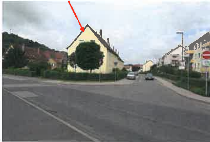
Außenansicht Eckbereich Hedwigsweg/Allendestraße
