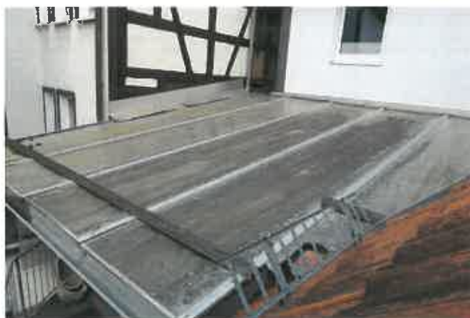
Überdachung rückwärtige Terrasse
