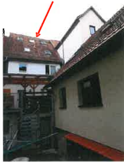
rückwärtige Ansicht Gebäude Auer Gasse 7
