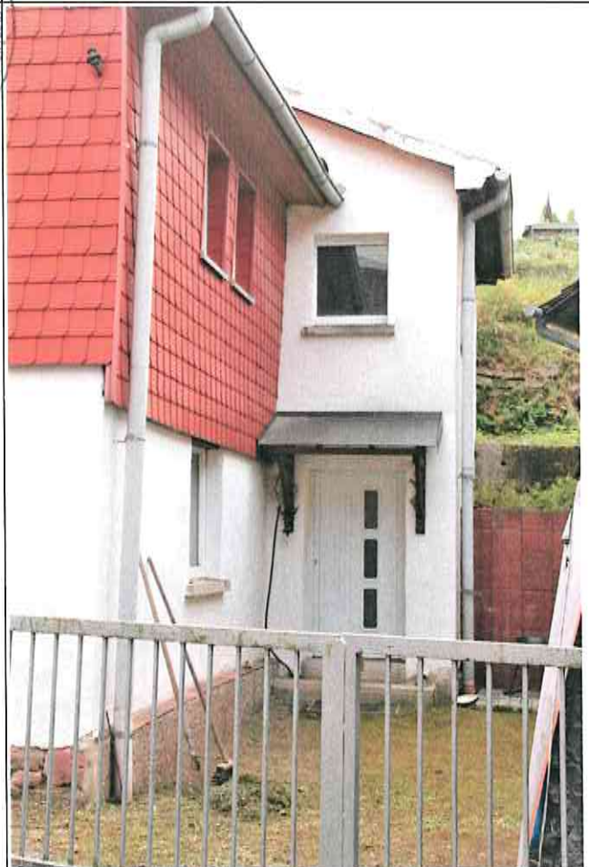
Wohnhausanbau Nordwestansicht, Eingang Wohnhaus
