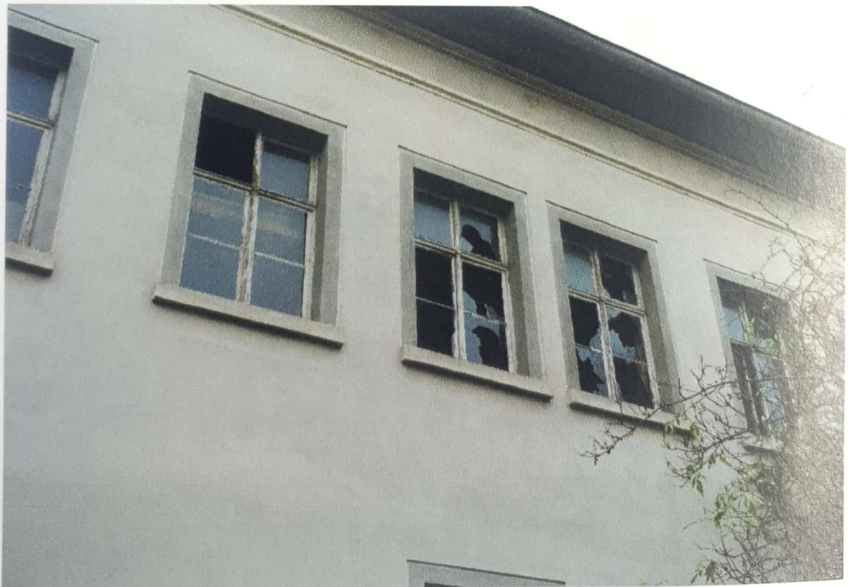
Bild 14: Zustand Fenster OG
