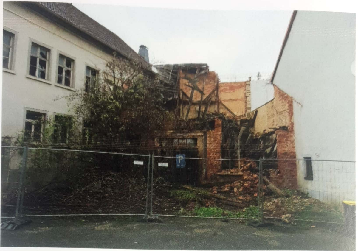
Bild 13: eingestürztes Gebäude auf dem Flurstück
