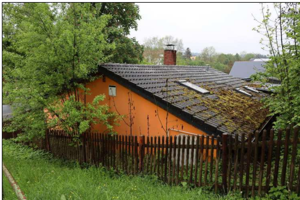
Nordansicht - ehemalige Gaststätte
