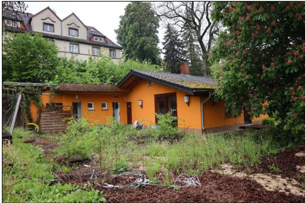
Südansicht - ehemalige Gaststätte
