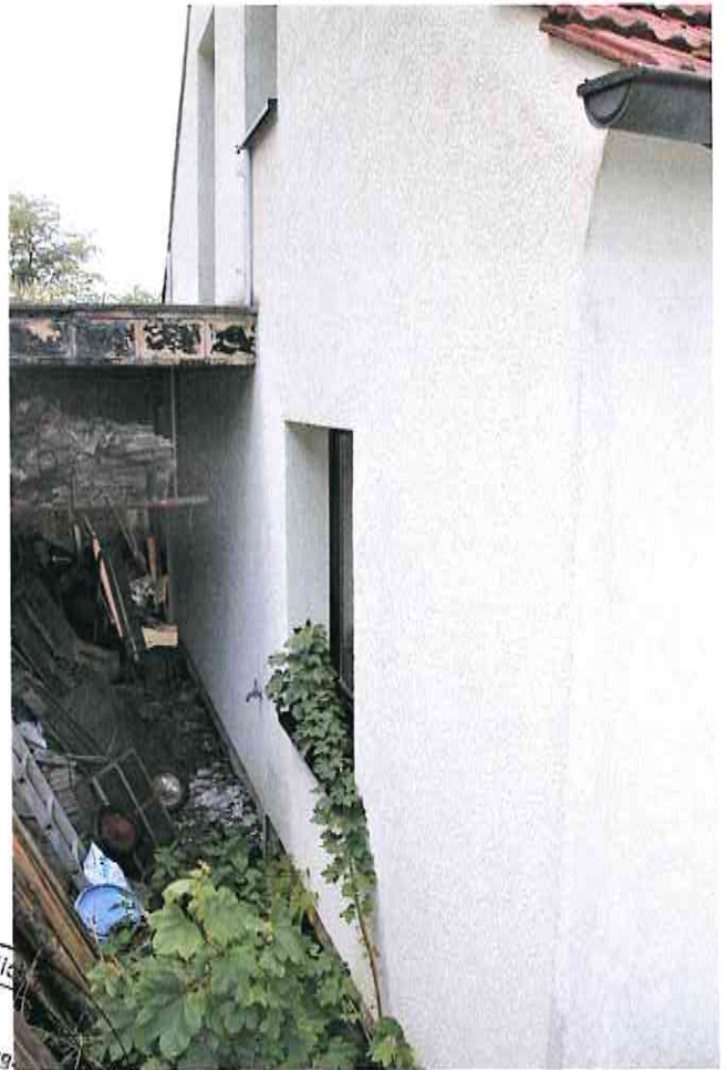
Flurstück 375/16 Wohnhaus Südostansicht mit Terrasse
