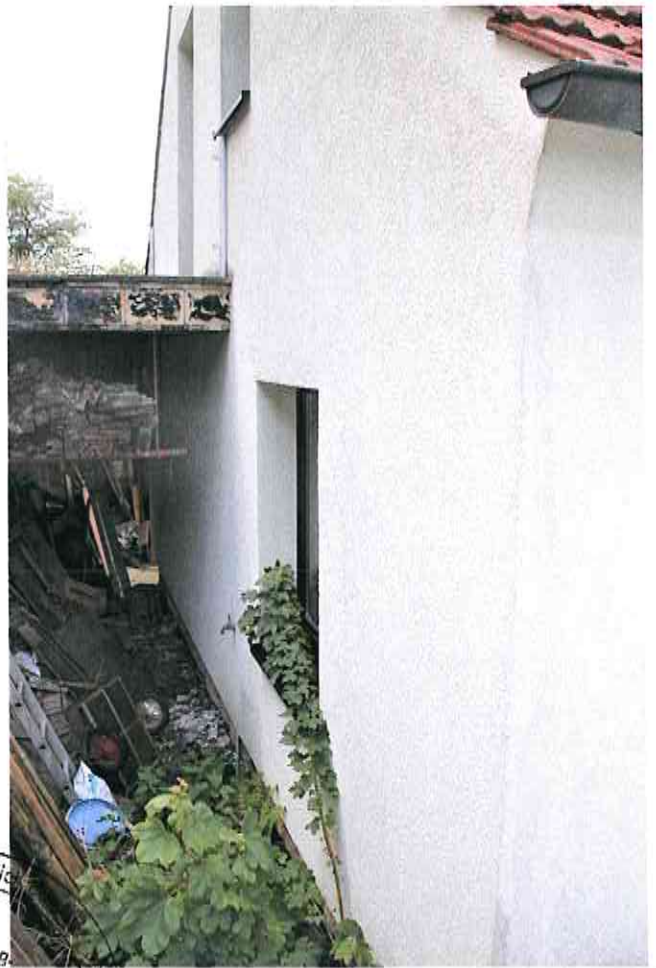
Flurstück 375/16 Wohnhaus Südostansicht mit Terrasse
