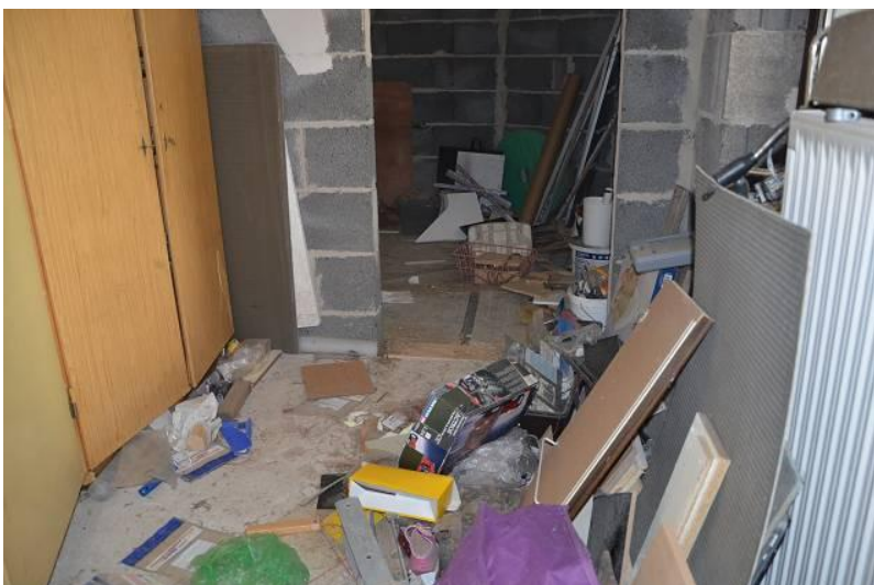
Foto 21 ABSTELLRAUM IM ERDGESCHOSS
