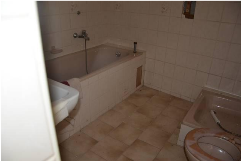
Foto 16 BAD IM ERDGESCHOSS
