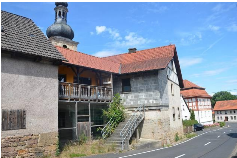
Foto 3 WOHNHAUS MIT ANBAU (AN NEBENGEBÄUDE ANGRENZEND UND FREITREPPE ZUM OG
