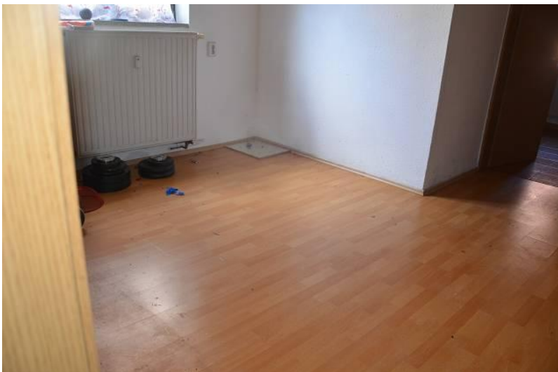
Foto 15 RAUM IM ERDGESCHOSS
