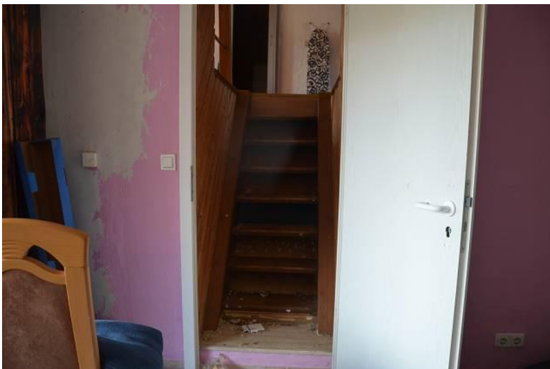
Foto 8 TREPPENRAUM ZUM ZIMMER IM DACH/ NEBENGEBÄUDE VOM WOHNZIMMER AUS ZUGÄNGLICH
