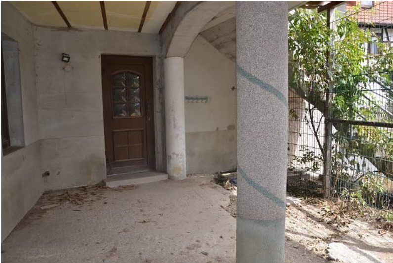
Foto 22 BEREICH UNTER BALKON ZUM BALKON
