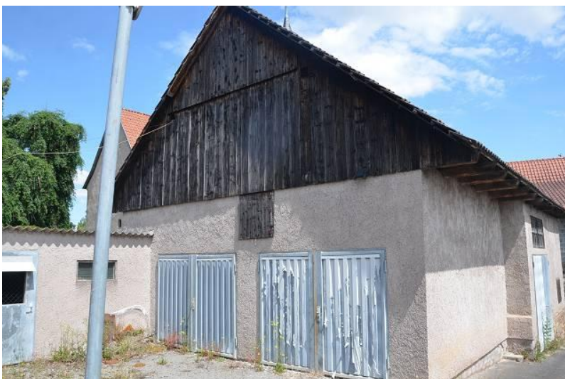
Foto 24 NEBENGEBÄUDE MIT ANBAU
