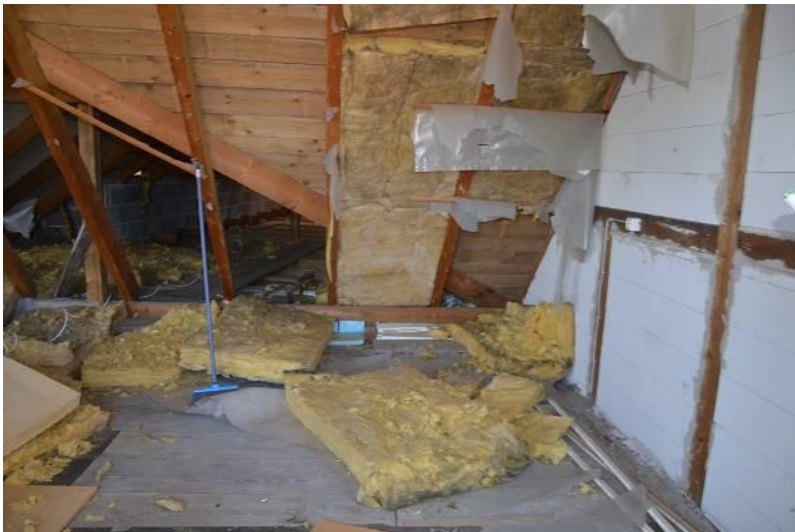
Foto 5 DACH WOHNHAUS UND ANBAU
