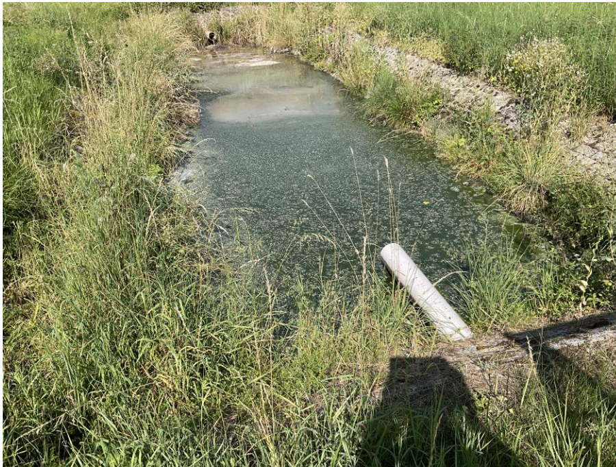
Absetzbecken Fäkalien Schlamm aktiv - untenstehend passiv
