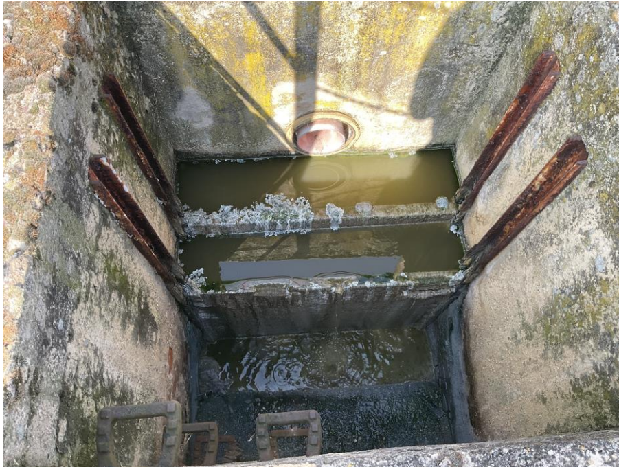
Kontrollschacht Abwasser auf dem Bewertungsobjekt
