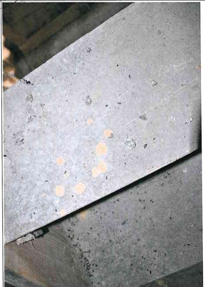
Wohnhaus (Zugang von Flurstück 89) Treppe zum Spitzboden- Befall tierische Holzschädlinge örtlich
