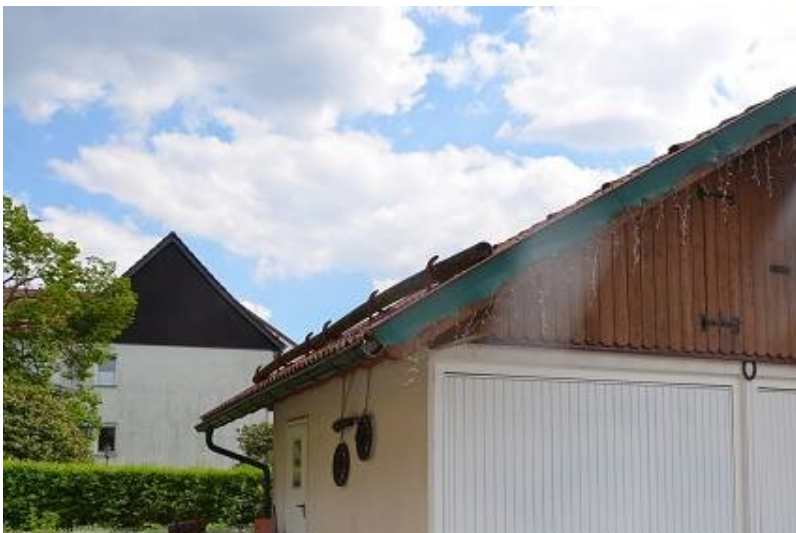
Foto 32 NEUE DOPPELGARAGE ANSICHT
