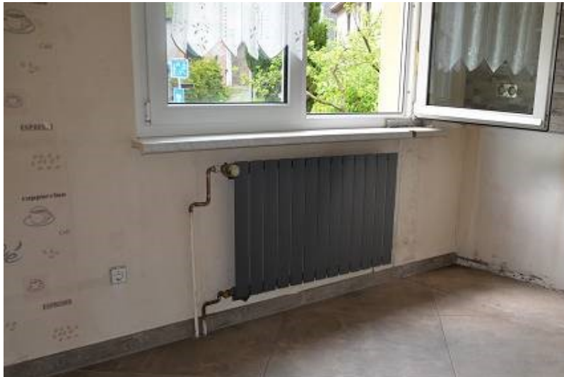
Foto 10 EHEMALIGE KÜCHE IM ERDGE- SCHOSS
