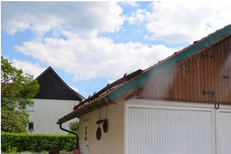
FOTO 32 NEUE DOPPELGARAGE ANSICHT
