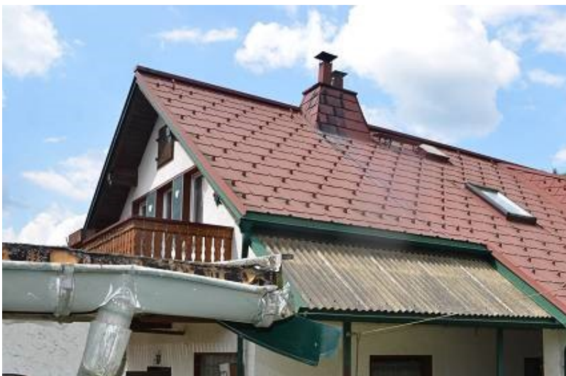
FOTO 18 SÜD- OST- ANSICHT
