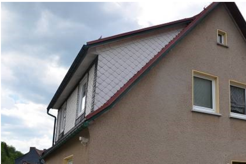
FOTO 2 SÜD- OST- ANSICHT
