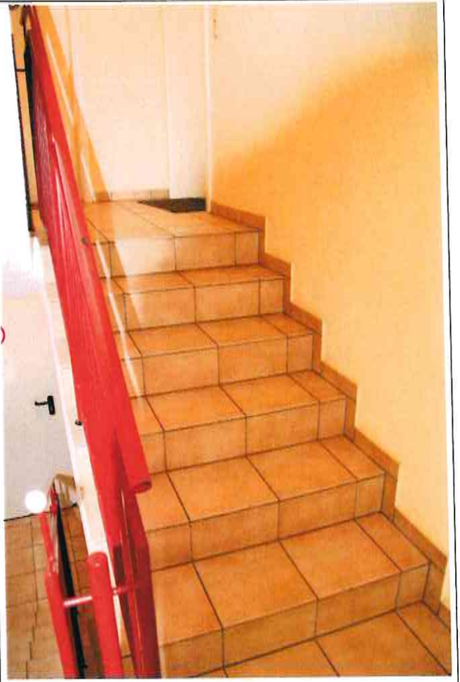
Wohnhaus Treppenraum Erdgeschoss
