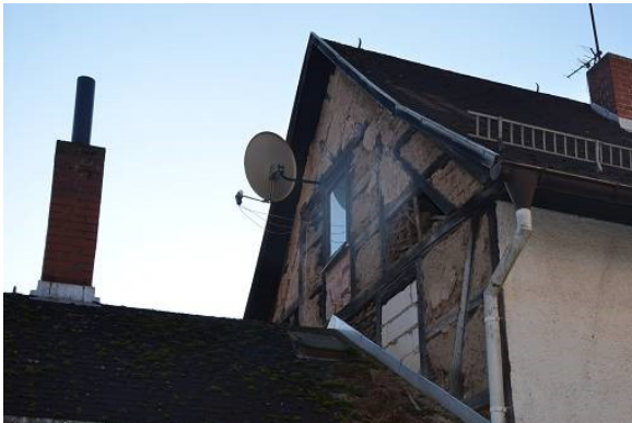
FOTOS 3-4 ANBAU IM HINTERRAUM
