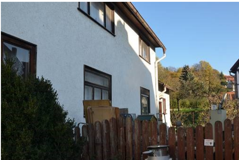
FOTO 2 SÜDANSICHT MIT ANBAU IM HINTERRAUM
