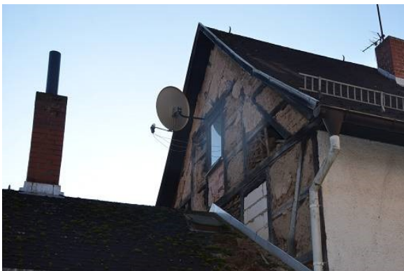
FOTOS 3-4 ANBAU IM HINTERRAUM
