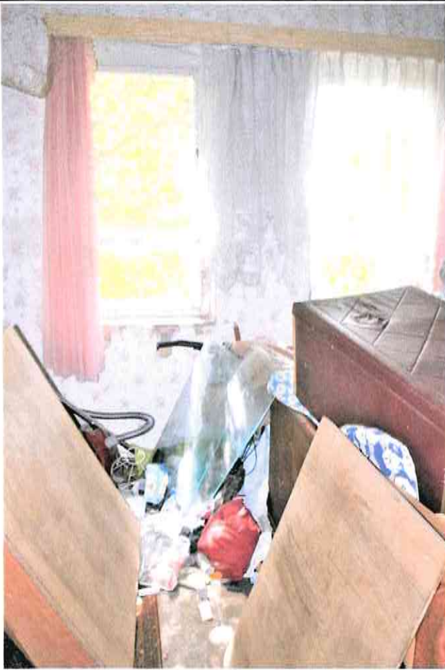
Wohnhaus Erdgeschoss Wohnraum
