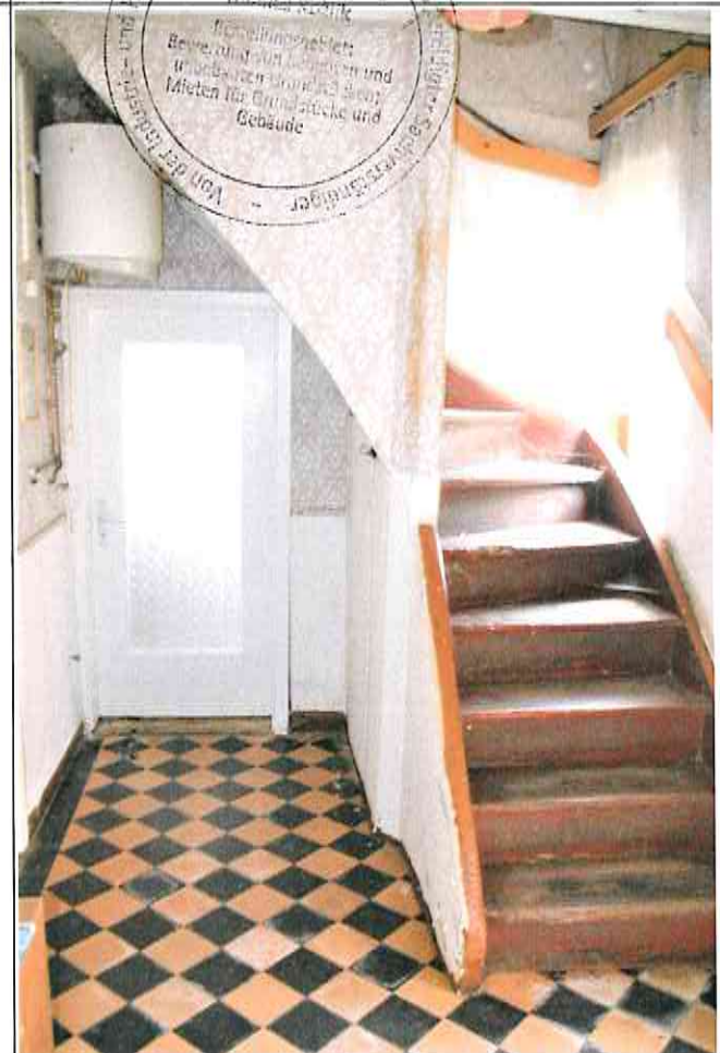
Wohnhaus Erdgeschoss Flur/Treppenraum
