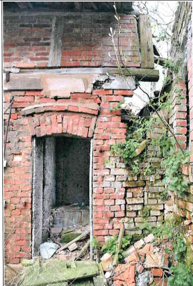
Nebengebäude Südwestecke zur Scheune
