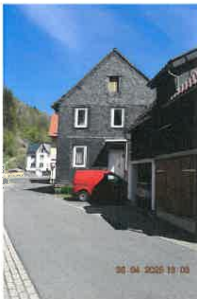
Giebelseite zur Schulstraße mit Hauseingang
