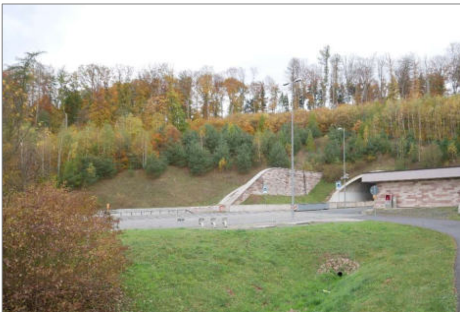
Gem. Bernterode, Flur 4, Flurstück 11 - Autobahn mit Tunnelportal
