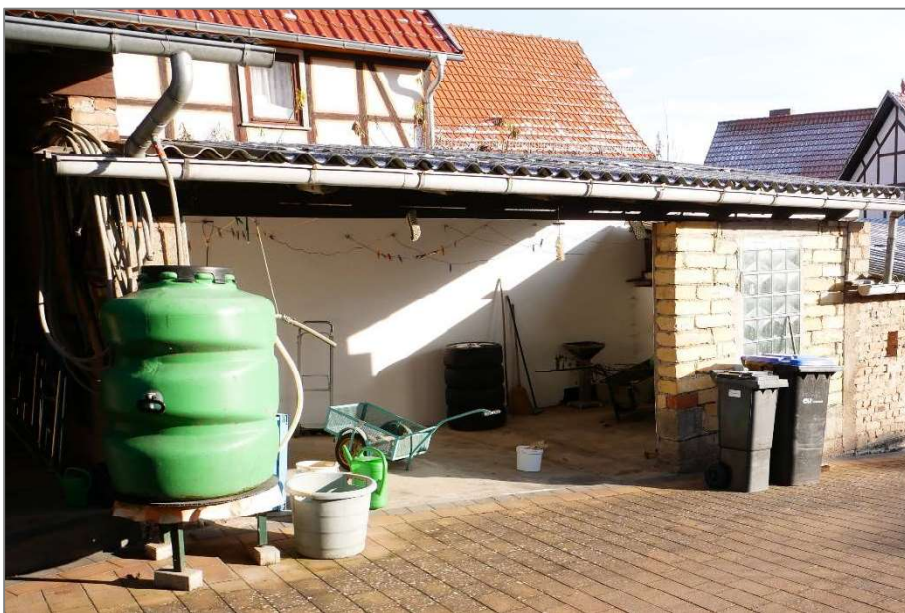
Überdachungen zwischen Garage und Nebengebäude
