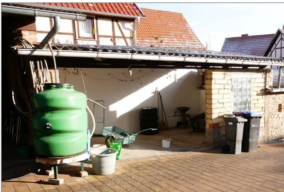
Überdachungen zwischen Garage und Nebengebäude
