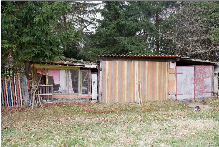
Flurstück 754/1 - Gartenhaus / Schuppen / ehem. Garagen
