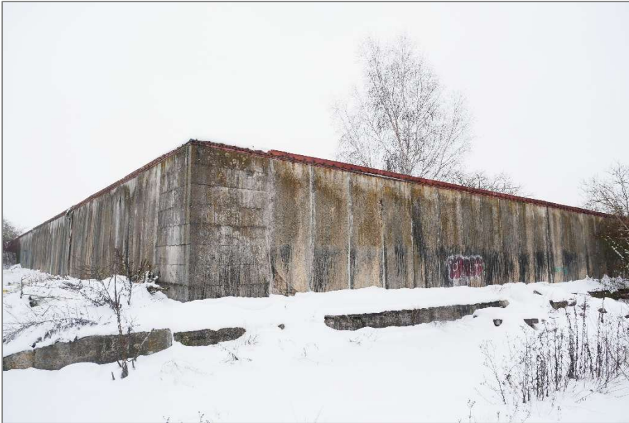
Straßenansicht von Nordwesten
