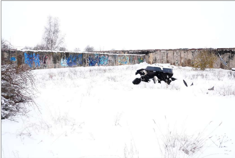
Ansicht innerhalb der Umfassungswände
