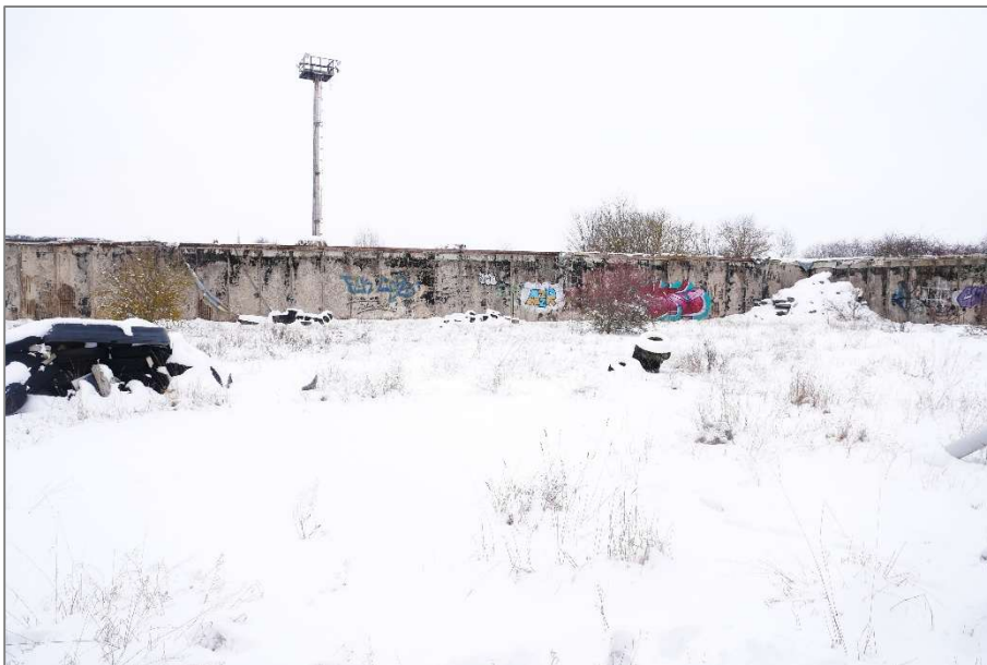
Ansicht innerhalb der Umfassungswände
