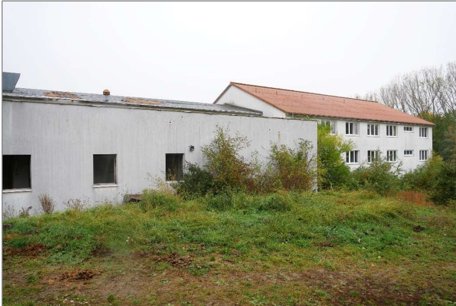
ehem. Wohnheim - westliche Anbauten - Nordwestansicht
