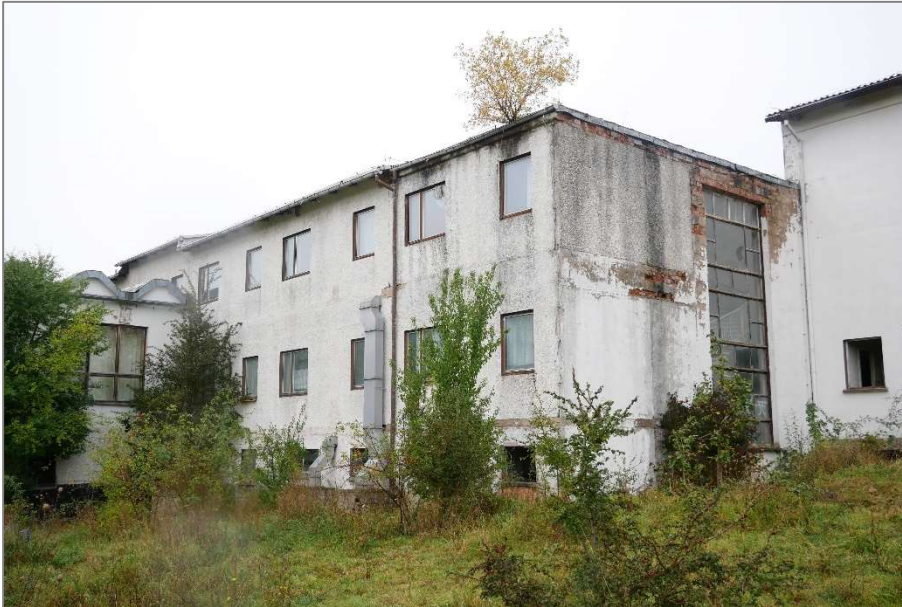
ehem. Wohnheim - Hauptgebäude - Südostansicht
