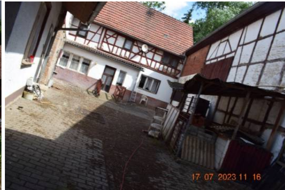
Hofansicht Wohnhaus und Stallgebäude
