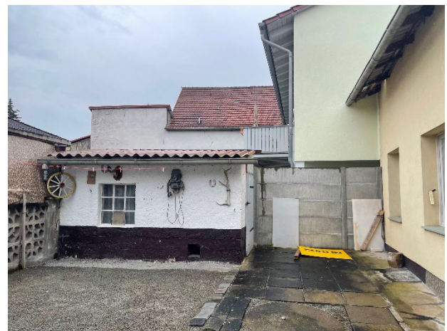
Hof mit Nebengebäude
