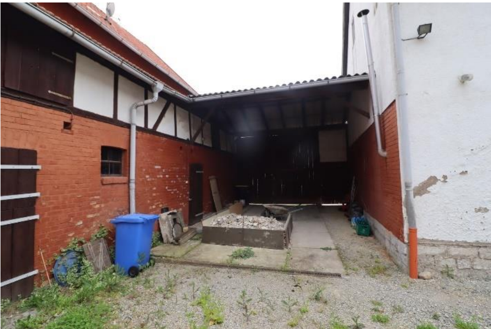
Hofansicht Torfahrt und Schuppen
