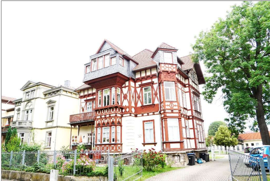
Wohnhaus / Vorderhaus - Südostansicht (Straßenansicht)
