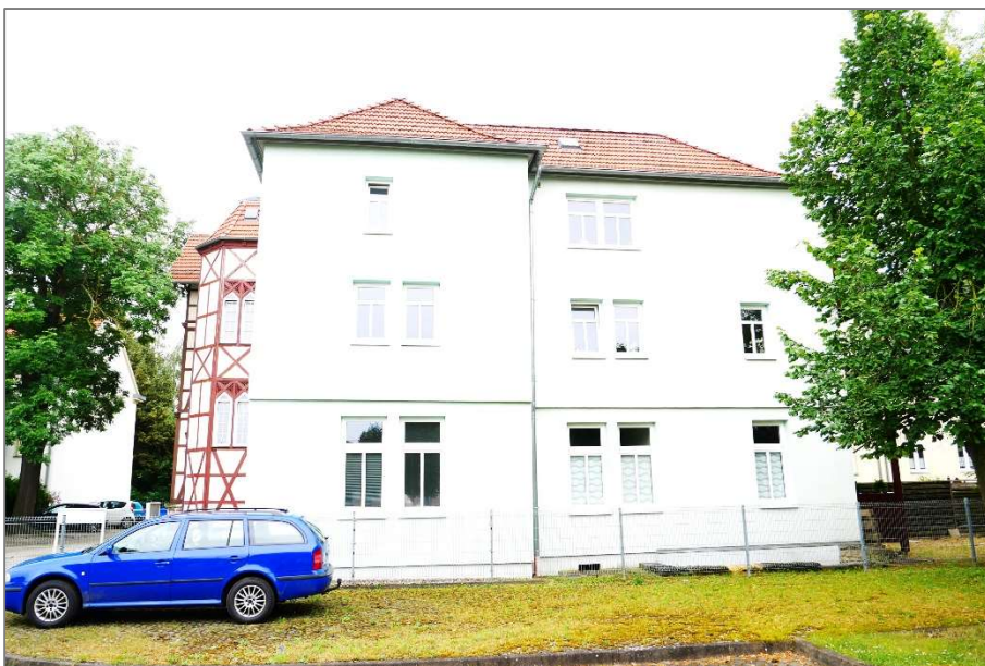
Wohnhaus / Hinterhaus - Nordansicht
