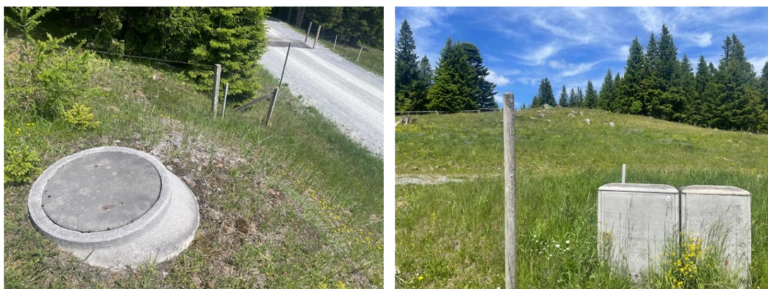
Abb.: Wasserversorgung und Strom (beide am Nachbargrundstück 3/13)
