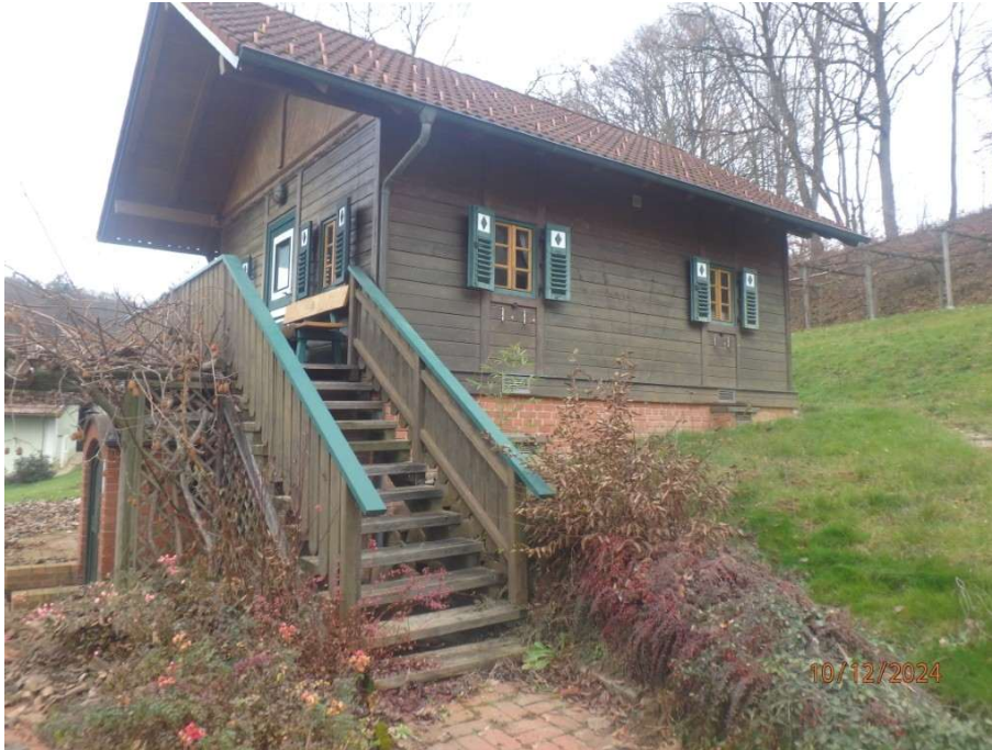
Gesamtaufnahmen des Kellerstöckls.
