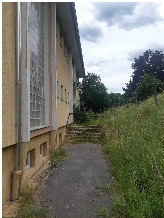
Westseite, Zugang zum Hauseingang
