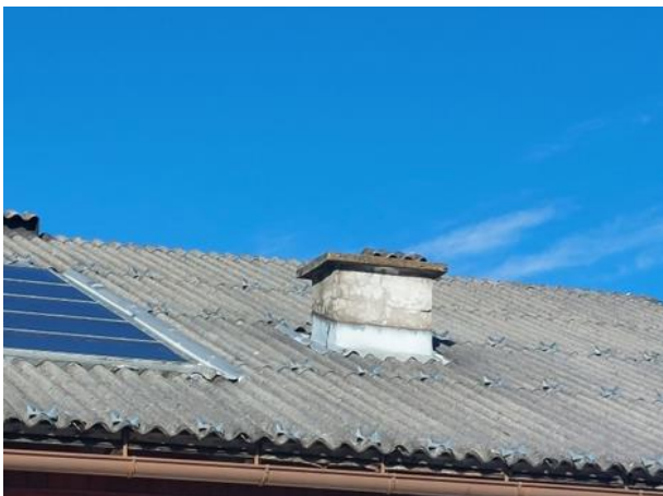
Abbildung 61 schadhafter Kamin
