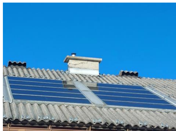
Abbildung 62 Solar Warmwasser
