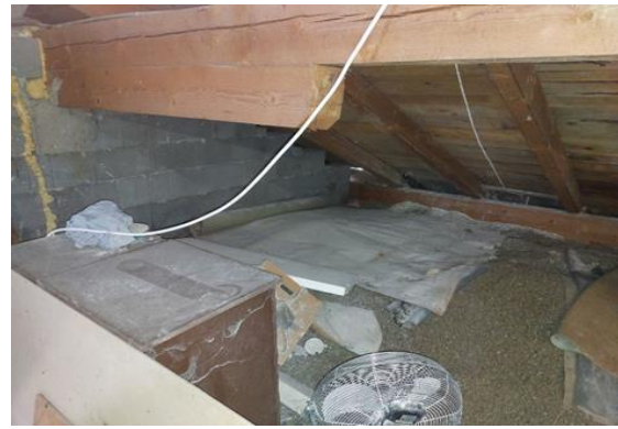
Abbildung 22 Schüttdämmung begonnen
