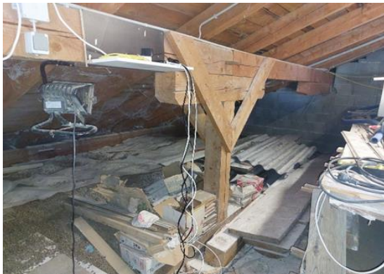
Abbildung 21 Lagerung von Baumaterial
