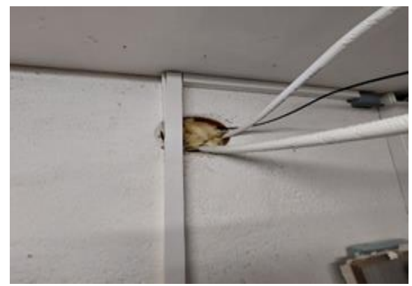
Abbildung 56 Rohrdurchführung Mangel!
