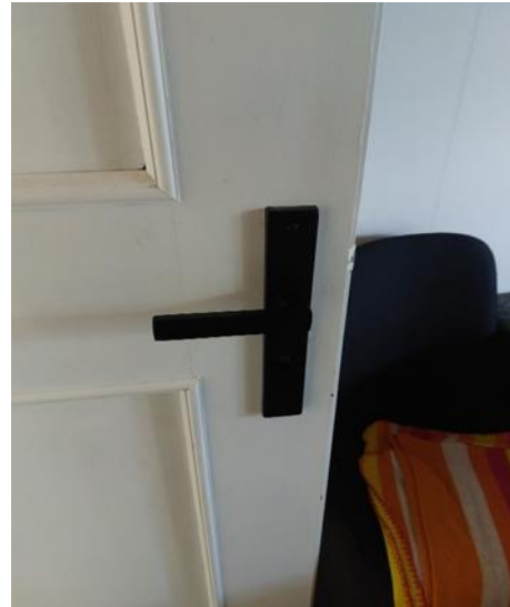
Abbildung 26 Innentür Massiv Drücker alt
