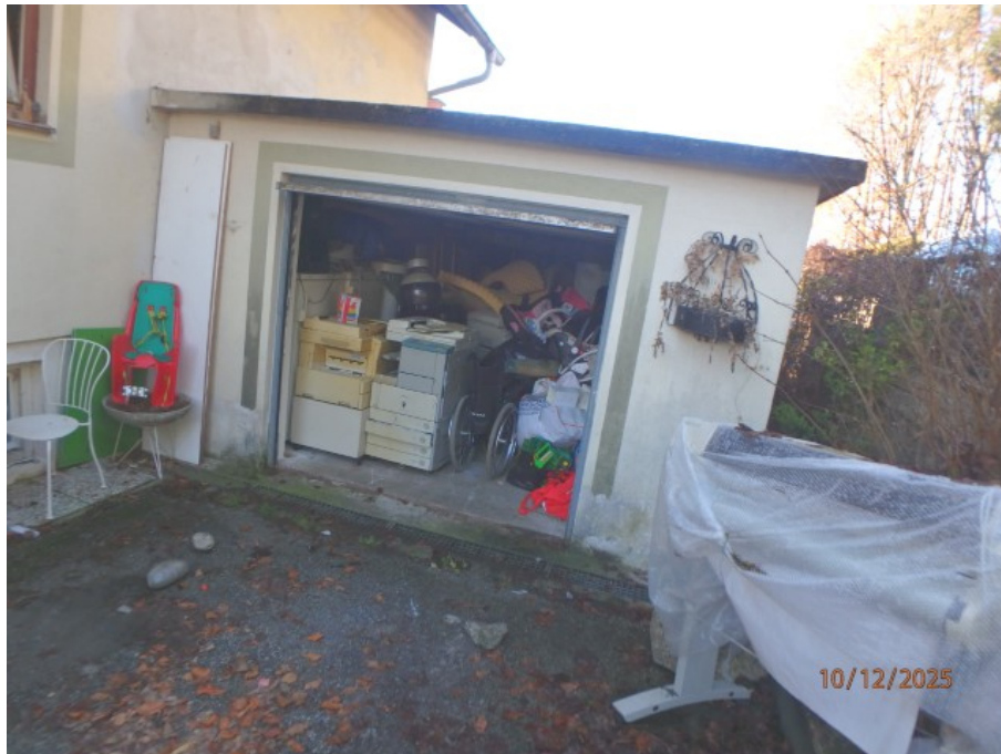
Gesamtaufnahmen des Garagengebäudes.
