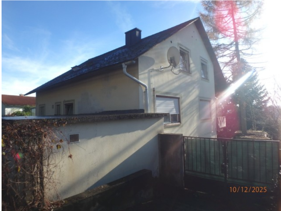
Gesamtaufnahmen des Wohngebäudes.
