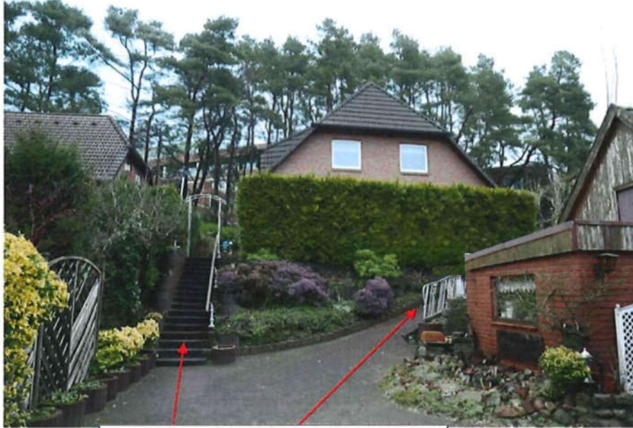
Treppe und Rampe
