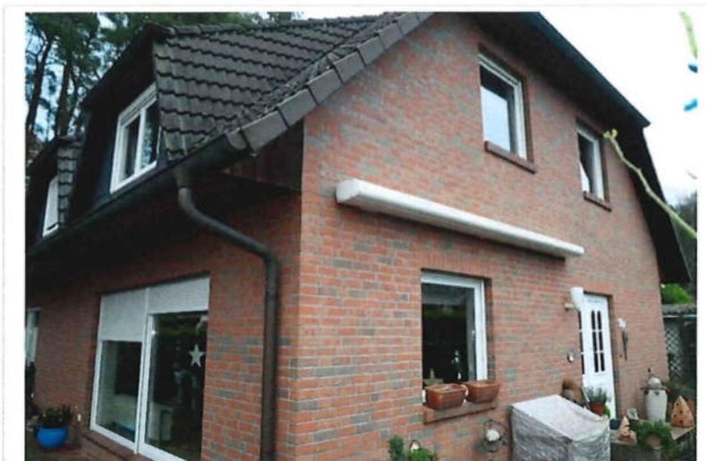
Bild 6: Südwestansicht (SE Nr. 1), mit Hauseingang
