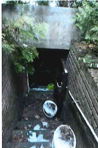
Bild 10: Zugang zum Keller im Bereich des Gemeinschaftseigentums
