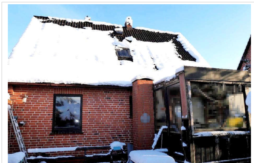
Bild 6: Westansicht mit Anbau aus 1984
