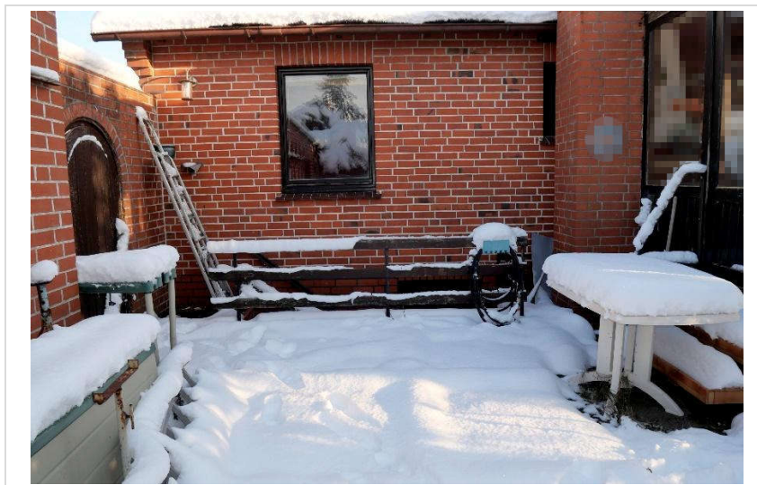
Bild 8: Westansicht mit Terrasse
