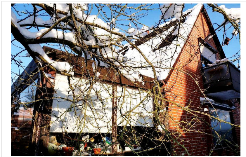
Bild 5: Südansicht mit Anbau
