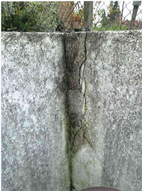
Bild 23: Situation Betonwand / Stützwand Garagenzufahrt
