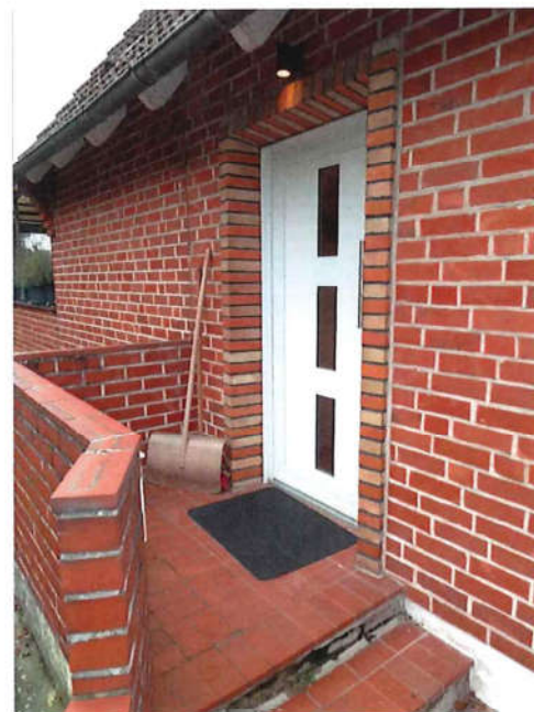
Bild 32: Bereich Eingangspodest / Haustür
