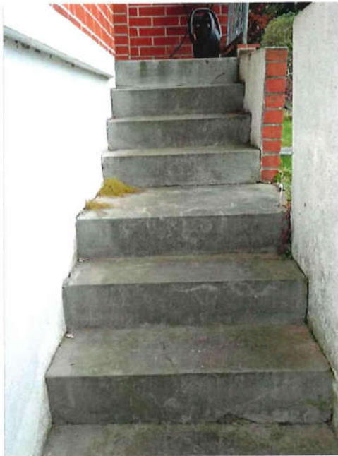
Bild 29: Treppenanlage Bereich Garage / rückwärtiges Grundstück
