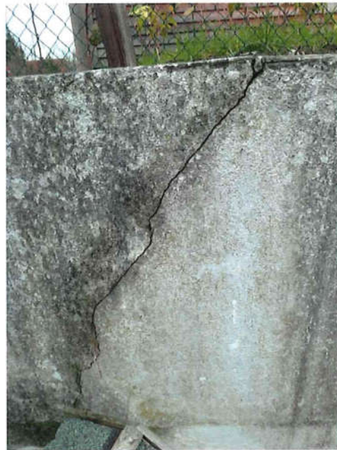
Bild 22: Situation Betonwand / Stützwand Garagenzufahrt
