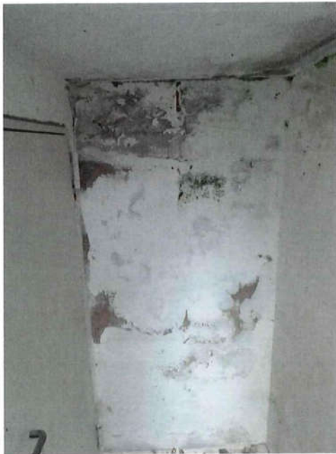
Bild 13: Situation Kelleraußentreppe / Zugang Keller
