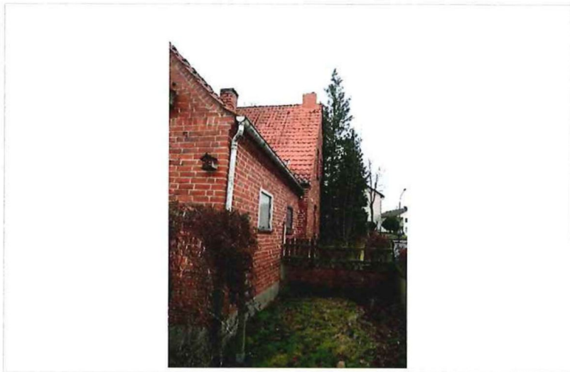
Bild 8: Nördliches Grundstück und nördliche Fassade
