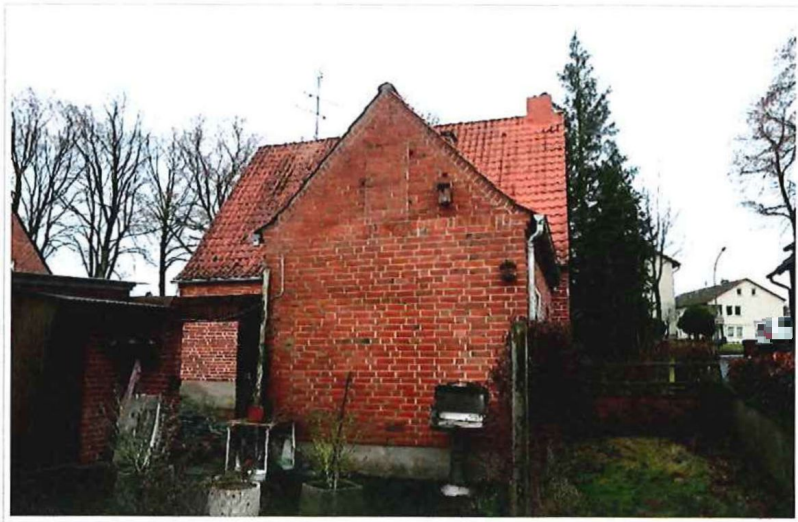
Bild 7: Nordostansicht Anbau, dahinter Wohnhaus
