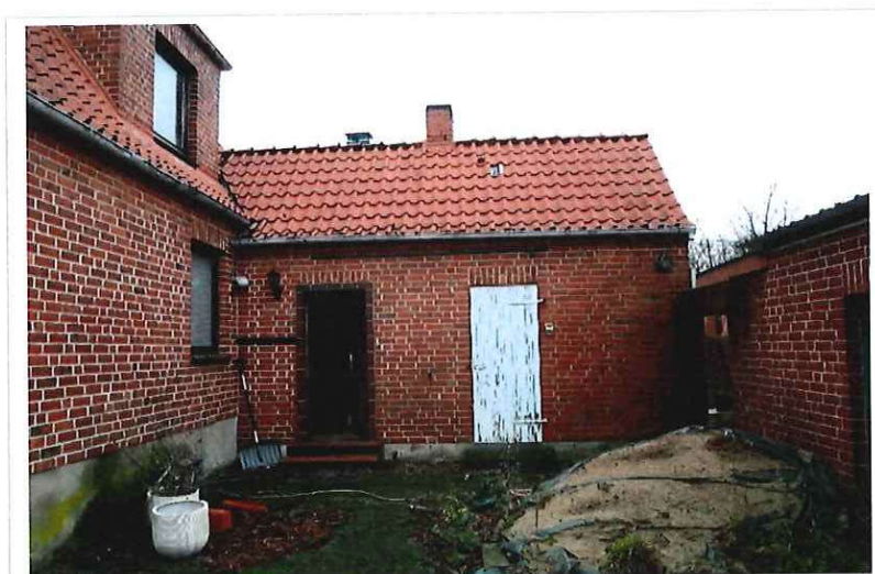
Bild 6: Südostansicht Anbau (Türen zur Waschküche und zum ehem. Stall)
