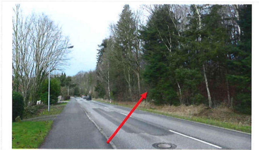
Bild 2: Südliche Grundstücksgrenze Blickrichtung West
