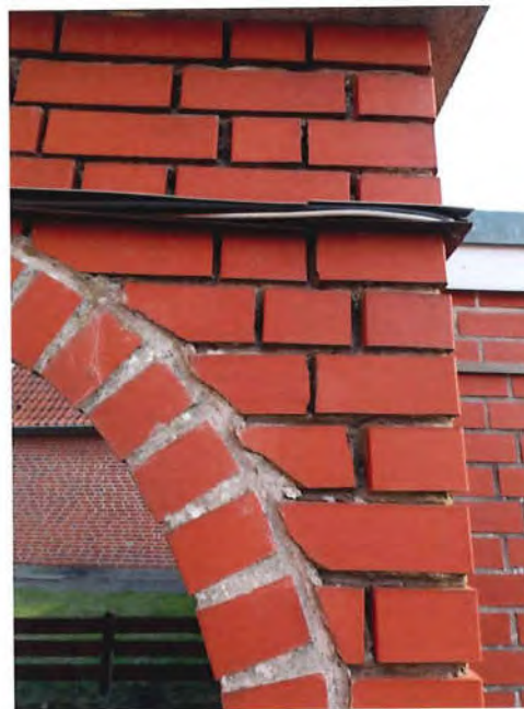
Bild 66: Situation Torbogen Verfugung etc.
