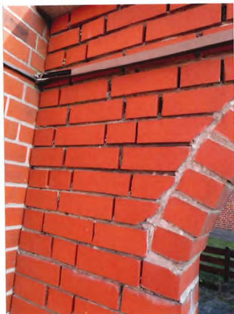
Bild 67: Situation Torbogen Verfugung etc.
