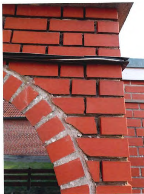
Bild 66: Situation Torbogen Verfugung etc.
