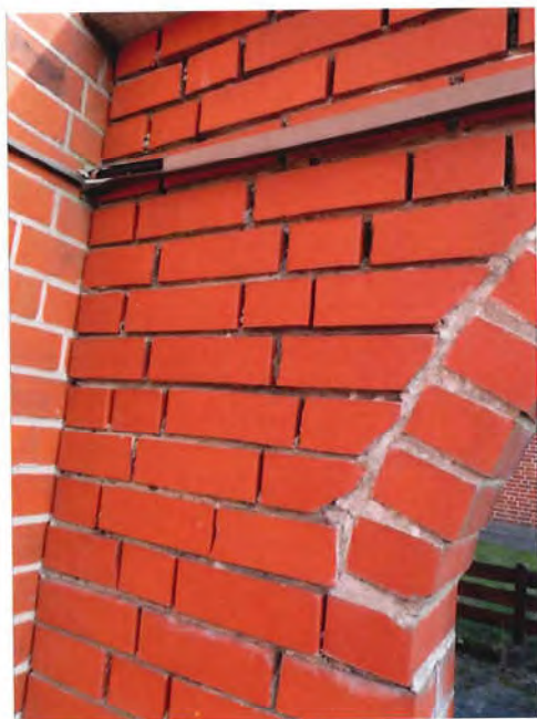
Bild 67: Situation Torbogen Verfugung etc.
