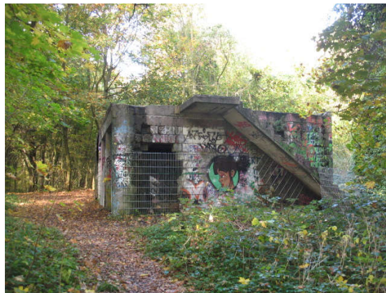
Betonbunker auf Flurstück 57/1
